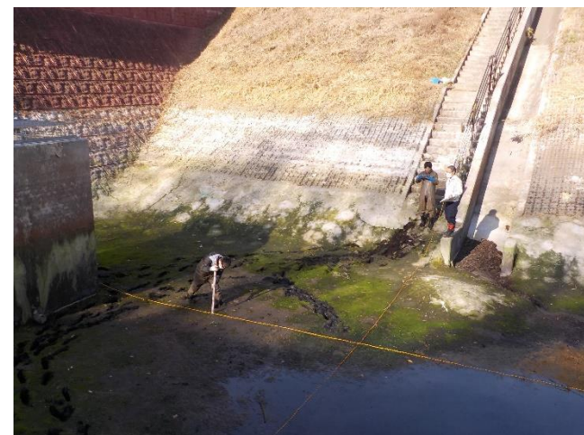
【地点②で計測をしている状況】
