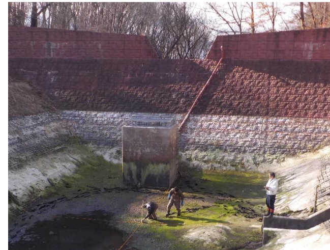
【中心点で計測をしている状況】
